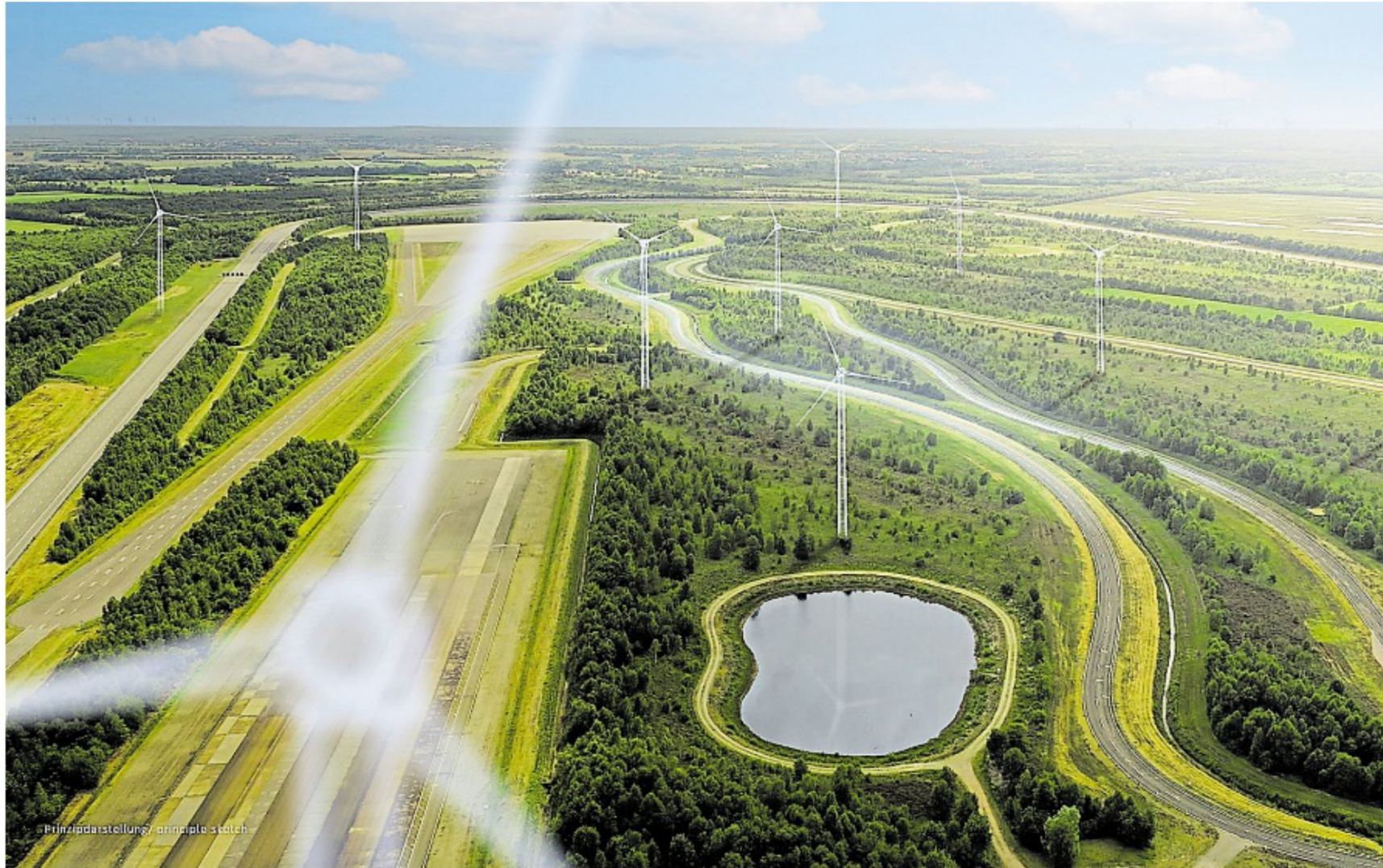
Im südlichen Teil des ATP-Prüfgeländes sollen insgesamt 20 Windenergieanlagen errichtet werden.
